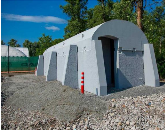
Рис. 1. Швидкоспоруджувальна захисна споруда модульного типу (ШЗСМТ)
